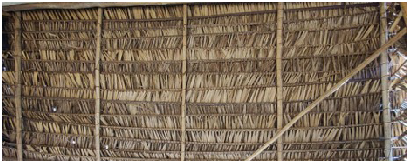
Foto 13: Paños de hojas de motacú para uso en la construcción de techos (San Salvador)
